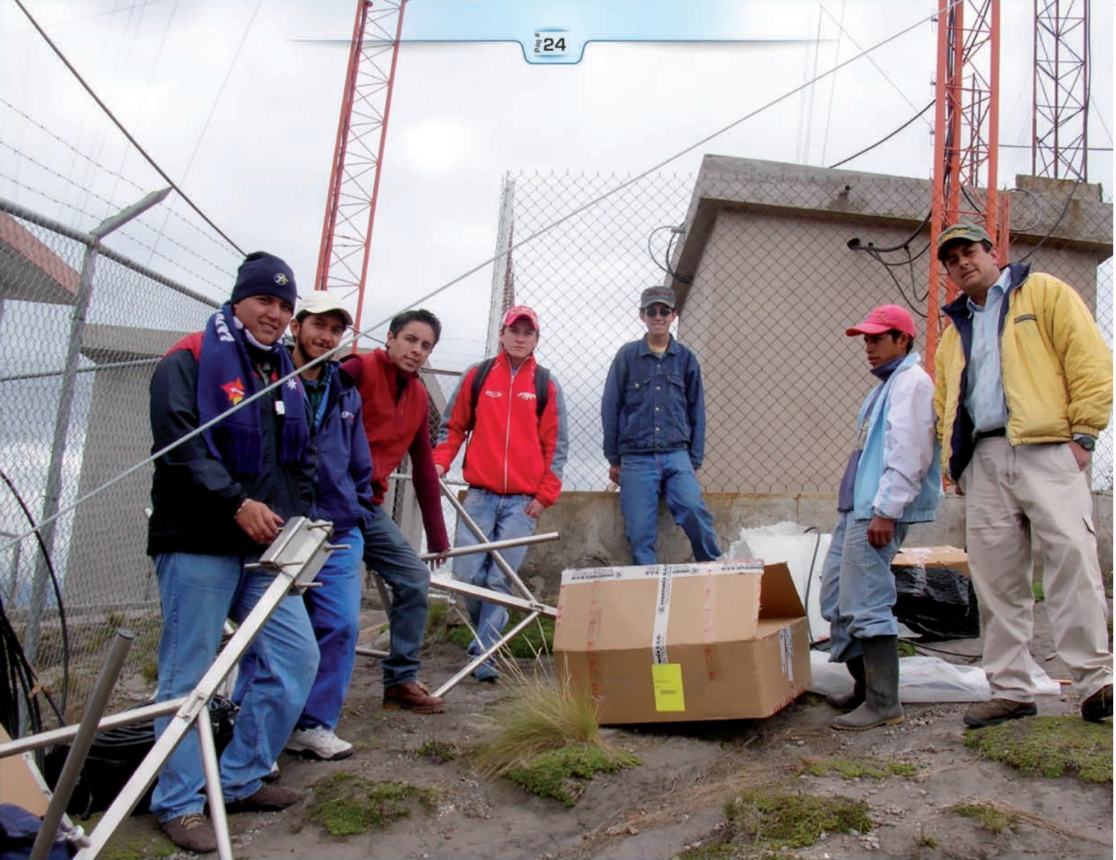
Instalación de transmisores y antenas en el cerro Igñu - Cacha
